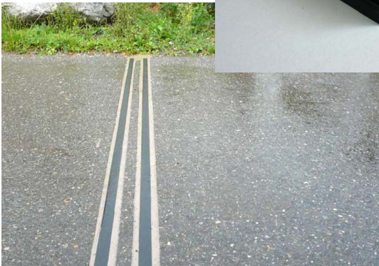
Opto-Sensoren - eingebaut
